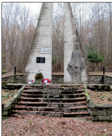
Pamätník SNP pred obnovou
