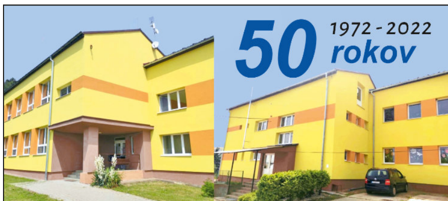
Súčasná budova školy po rekonštrukcii
