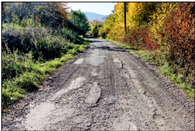
Pôvodný stav cesty pred rekonštrukciou
